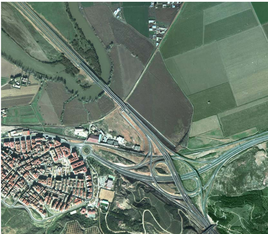
Figura 20: Infraestructuras viarias y áreas circundantes degradadas.
